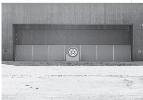
仮設から恒久施設になった的場
